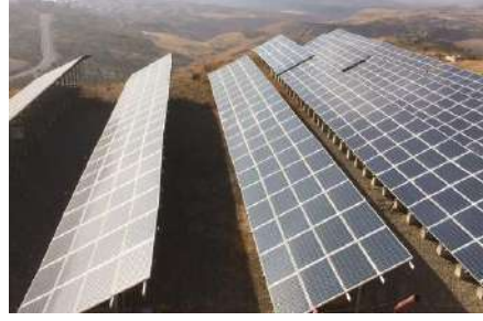
Şekil 2.3 Lebit Enerji güneş santrali görünümü
