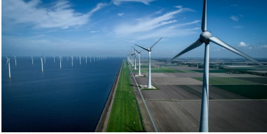
Şekil 2.1 Denizde (offshore) ve karada (onshore) kurulmuş rüzgâr türbini çiftliği [16]
